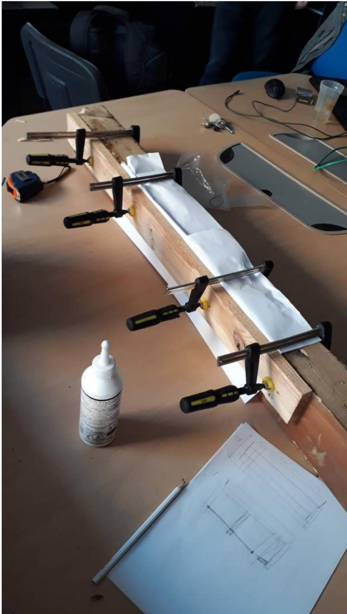
Prochaine étape, trouver un moyen d'avoir des poteaux lisses pour pouvoir les coller (tests de ponçage à la ponceuse à bande, vérifier si quelqu'un a de grands serres joints @jfm et @gofannon)
