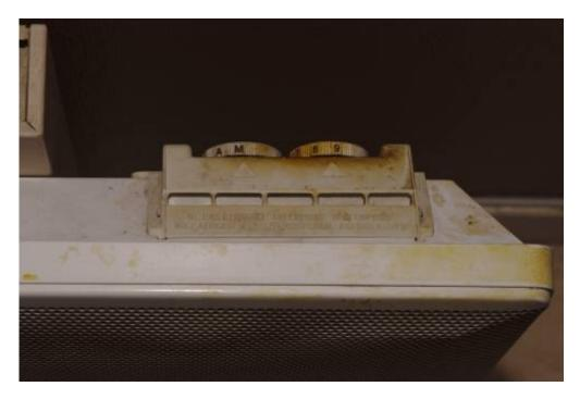
Pour tester le bon fonctionnement de cette partie, il suffit d'utiliser la télécommande fournie avec la prise: à l'arrêt le radiateur est éteint, en marche le radiateur doit chauffer au maximum sans arrêt.
